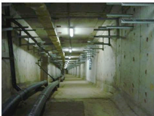
图4 现浇成型管廊
